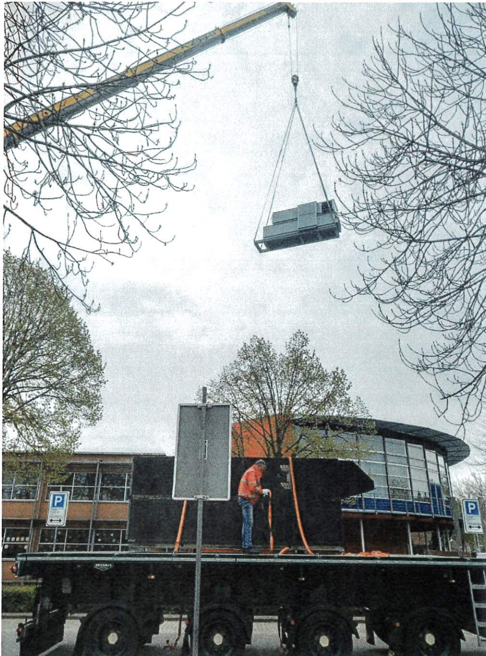
2021: Nieuwe ventilatieapparatuur wordt op het dak geplaatst
